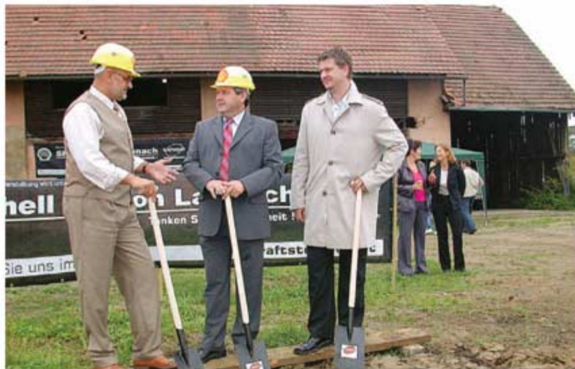
An der B 76 entsteht eine Station, errichtet nach den neuesten Erkenntnissen der Umwelttechnologie.
